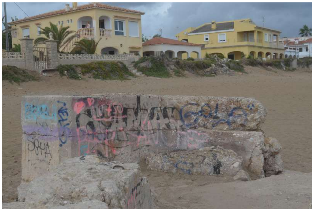
A.M.G. 005. Formigó armat i encofrats. Casamata les Deveses II.
