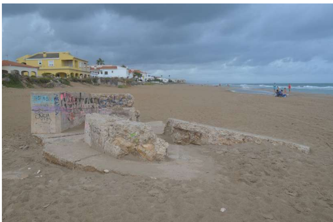
A.M.G. 004. Fotografia general nord. Casamata les Deveses II.
