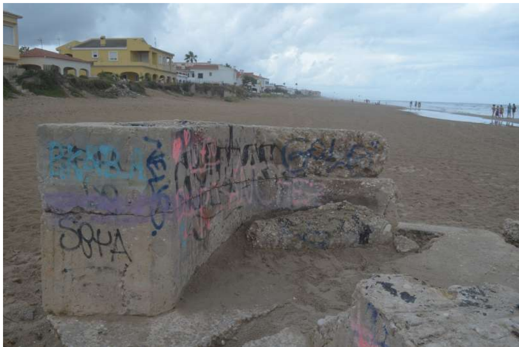
A.M.G. 007. Angle conformant el passadís. Casamata les Deveses II.
