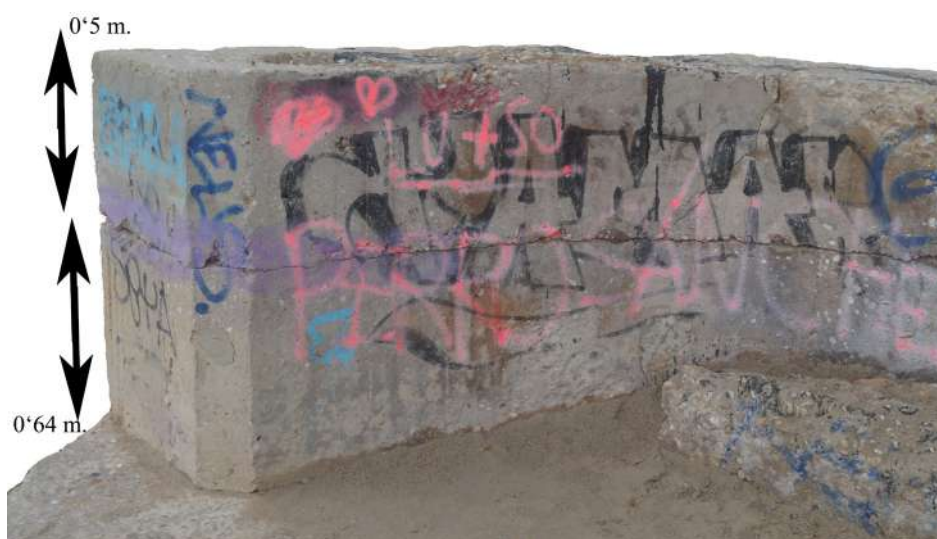
M.G.P. 002. Alçàries dels encofrats. Casamata les Deveses II.
