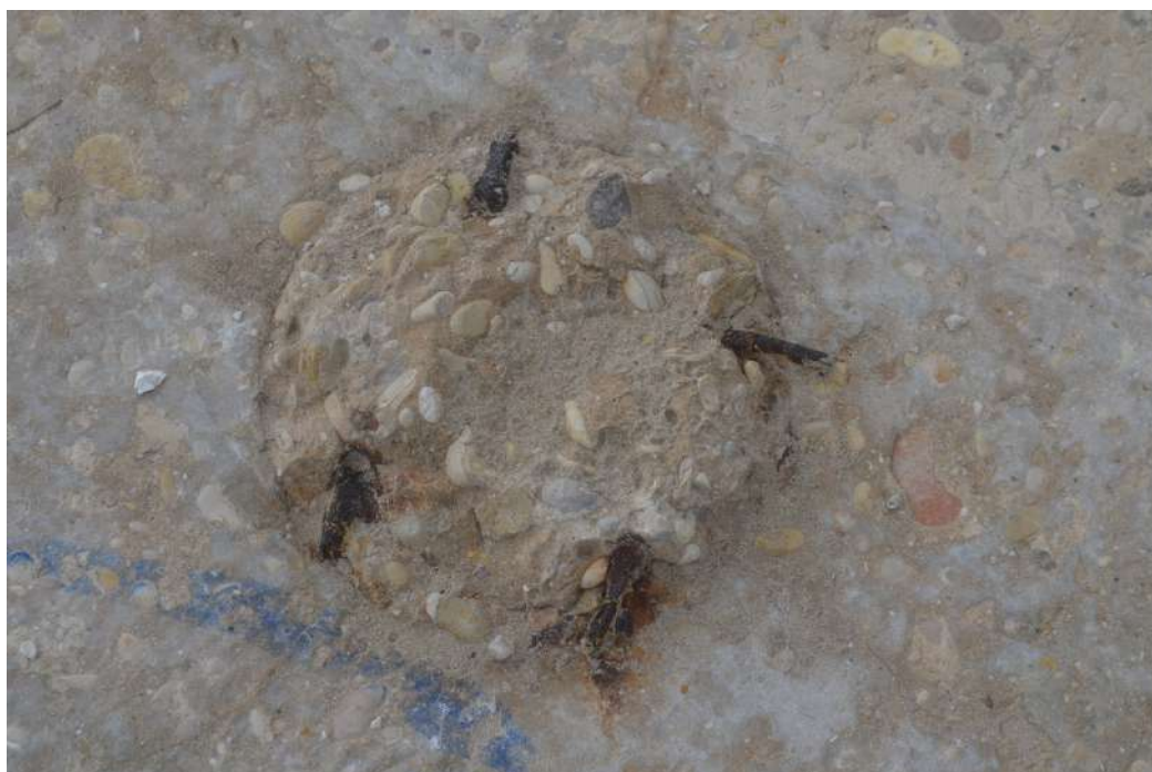
A.M.G. 008. Fotografia de detall. Suport de metralladora. Casamata les Deveses II.
