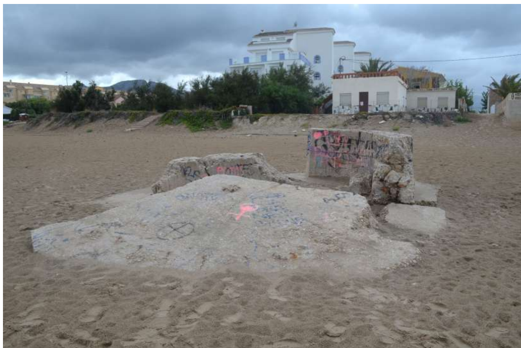
A.M.G. 003. Fotografia general sud. Casamata les Deveses II.
